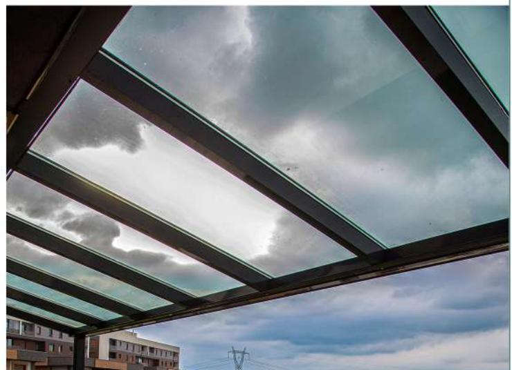
Es wird in das Profil abgeleitet und von dort über die Trägerpfosten an der Vorderseite nach außen geführt. Das Wasser auf den Gläsern in den Trägerprofilen wird dank der Neigung nach vorne geleitet.
