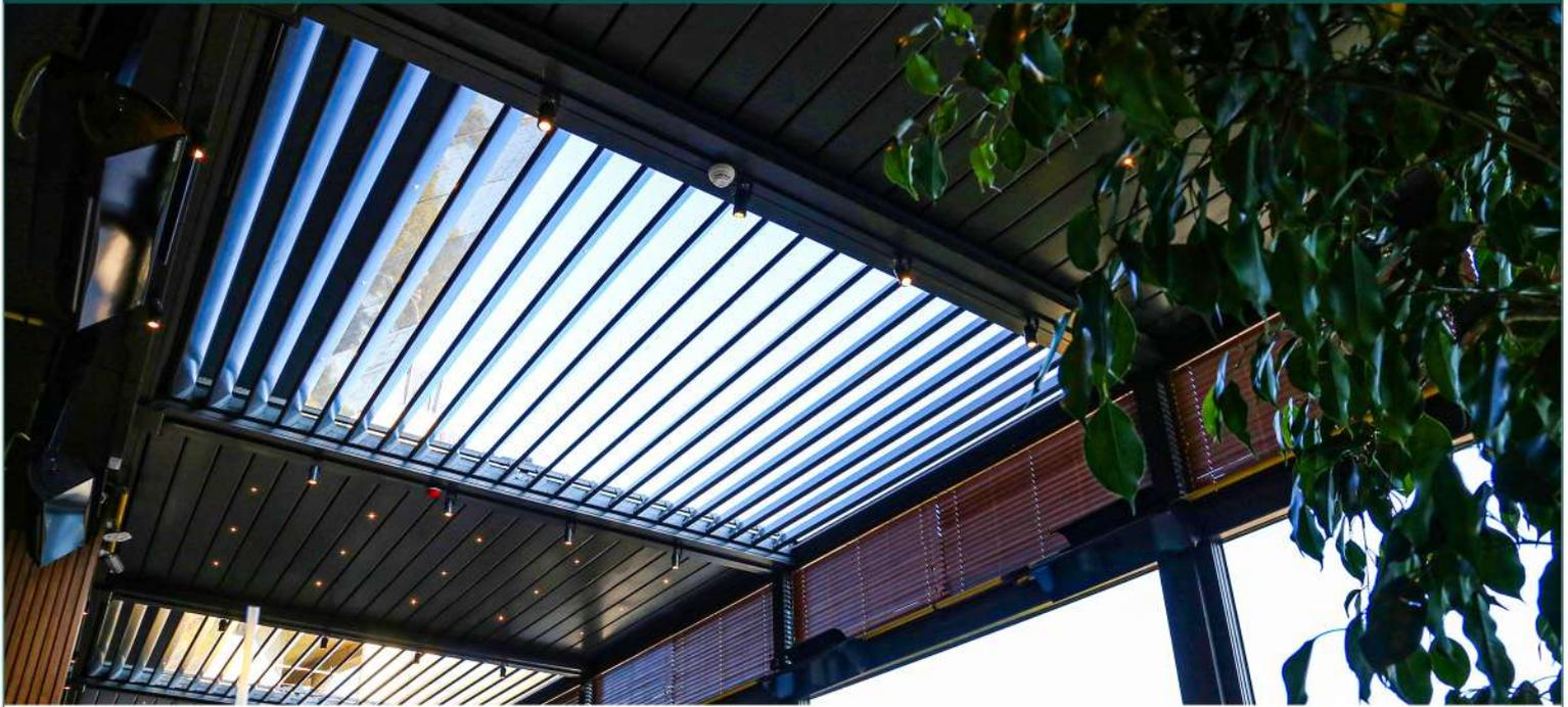
**Bioffen** ist eine Pergola vom Typ „bioklimatisch“ aus der bioklimatischen Familie, die sich um ihre Achse bewegen kann. Die Aluminiumplatten, aus denen die Decke besteht, drehen sich über einen im System integrierten Motor und ermöglichen so eine offene, geschlossene oder halboffene Deckenkonstruktion.
