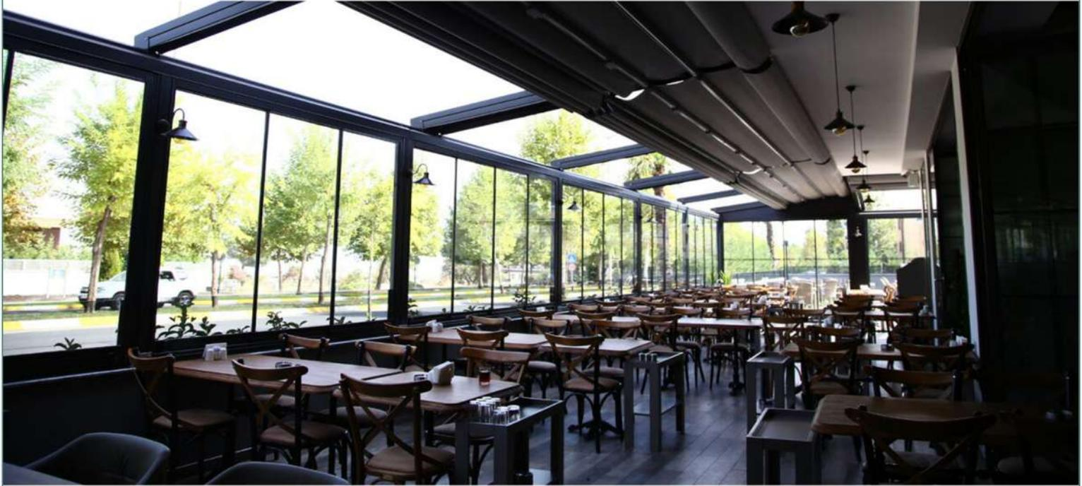
Das System wird auf Schienenprofilen im oberen und unteren Teil des Glases montiert, die aus mindestens 2, maximal 4 Flügeln für die einseitige Bewegung und mindestens 4, höchstens 8 Flügeln für die beidseitige Bewegung bestehen. Das System bietet **zwei Arten** von Standardgriffoptionen: **Drehstangenschloss** und **Hakeneinsteckschloss**.
