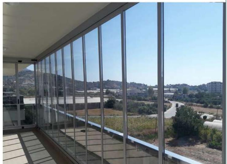
Dank der Kondensationsrinne wird ein direkter Lufteintritt von der Außenumgebung und eine schnelle Evakuierung verhindert.
