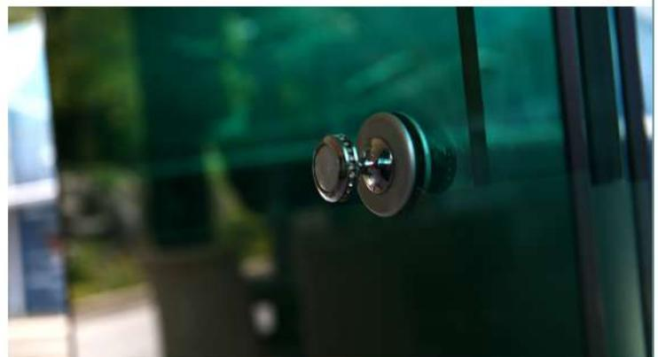
Durch die zusätzlichen Kunststoffstopper wird das Schwanken bei windigem Wetter minimiert.
