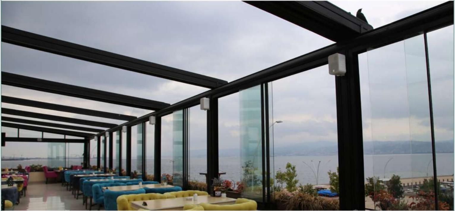
Das System wird auf Schienenprofilen an der Ober- und Unterseite des Glases montiert, das mit mindestens 3 und maximal 4 Flügeln für eine unidirektionale Bewegung ausgestattet ist. Das minimalistische Schließsystem am ersten und letzten Flügel bietet maximale Sicherheit für Ihre Anlage.
